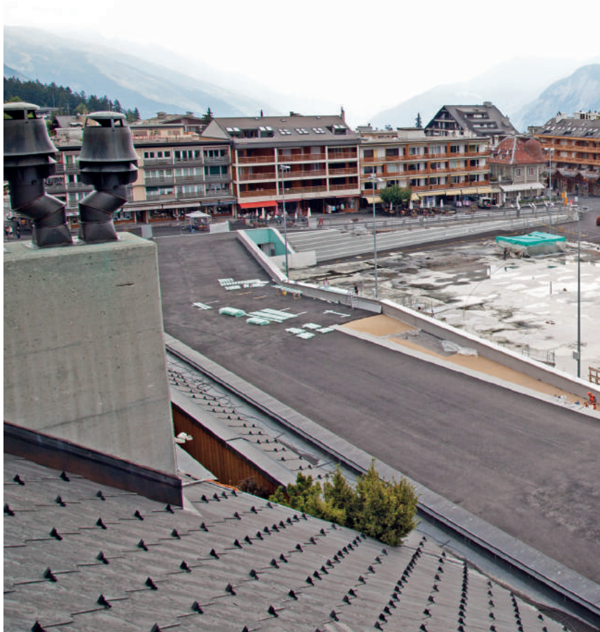
Le visage de Crans-Montana se modifie au fur et à mesure de l'avancement des travaux
