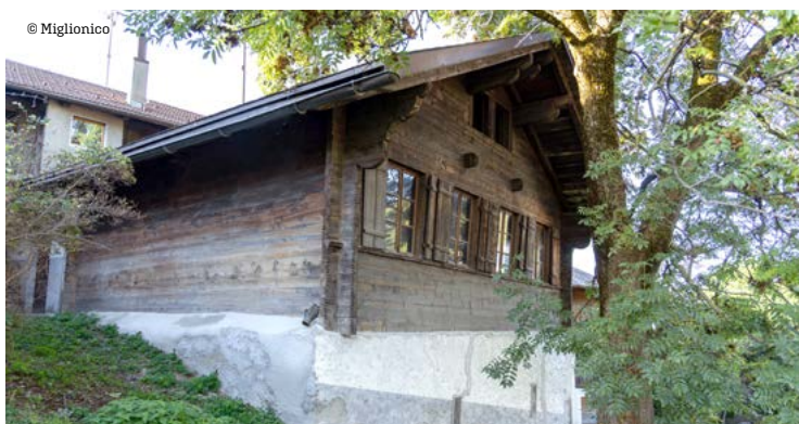
Grâce au rachat par la Bourgeoisie de Chermignon, la Maison de la Communauté pourra être restaurée dans le respect du patrimoine. Une fois rénovées, les salles pourront être louées au public.
